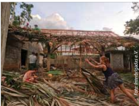
Interbrigadas helfen beim Decken eines traditionellen Palmendaches im Juli 2021
